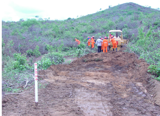
Fig 02. Desmatamento da EBV – IV Lote 13 . Encalço
